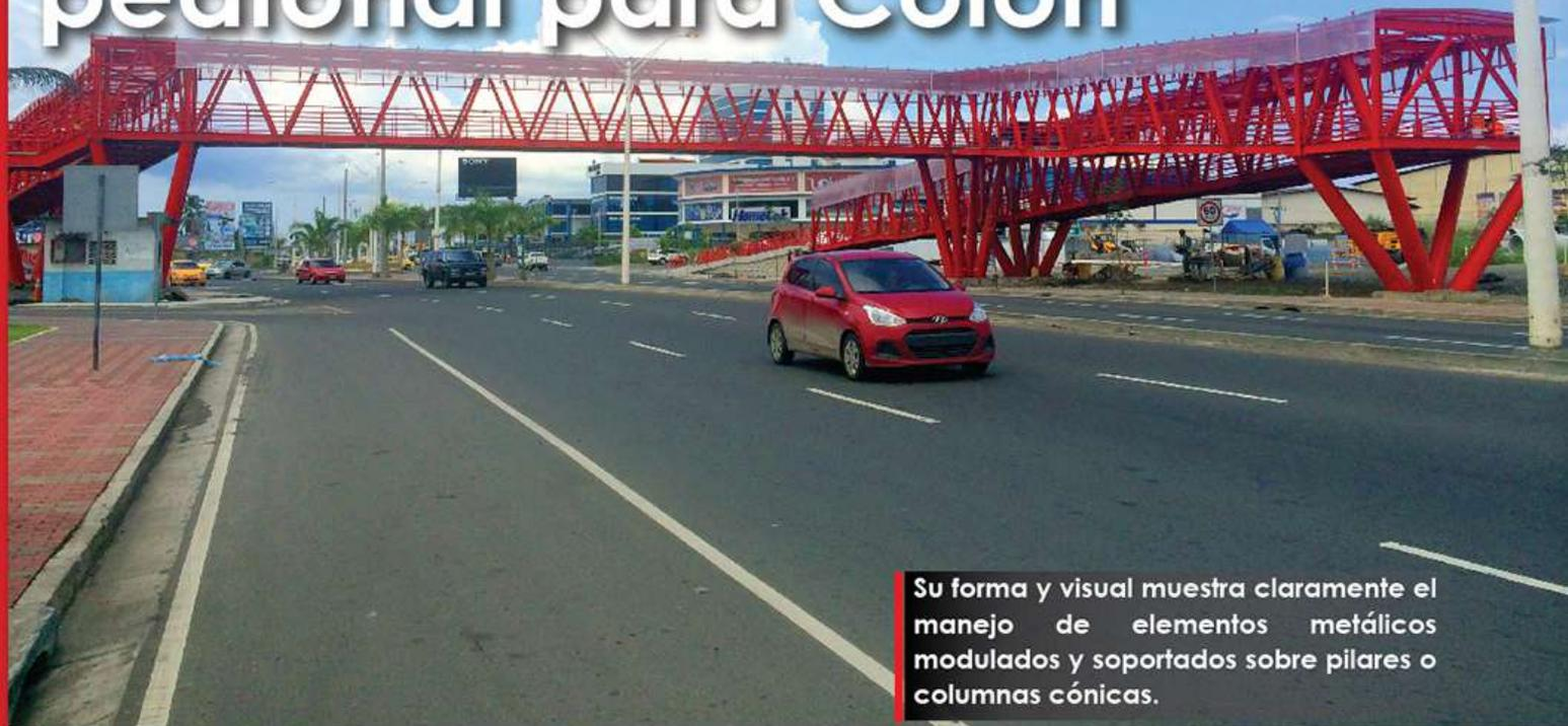
Su forma y visual muestra claramente el manejo de elementos metálicos modulados y soportados sobre pilares o columnas cónicas.
